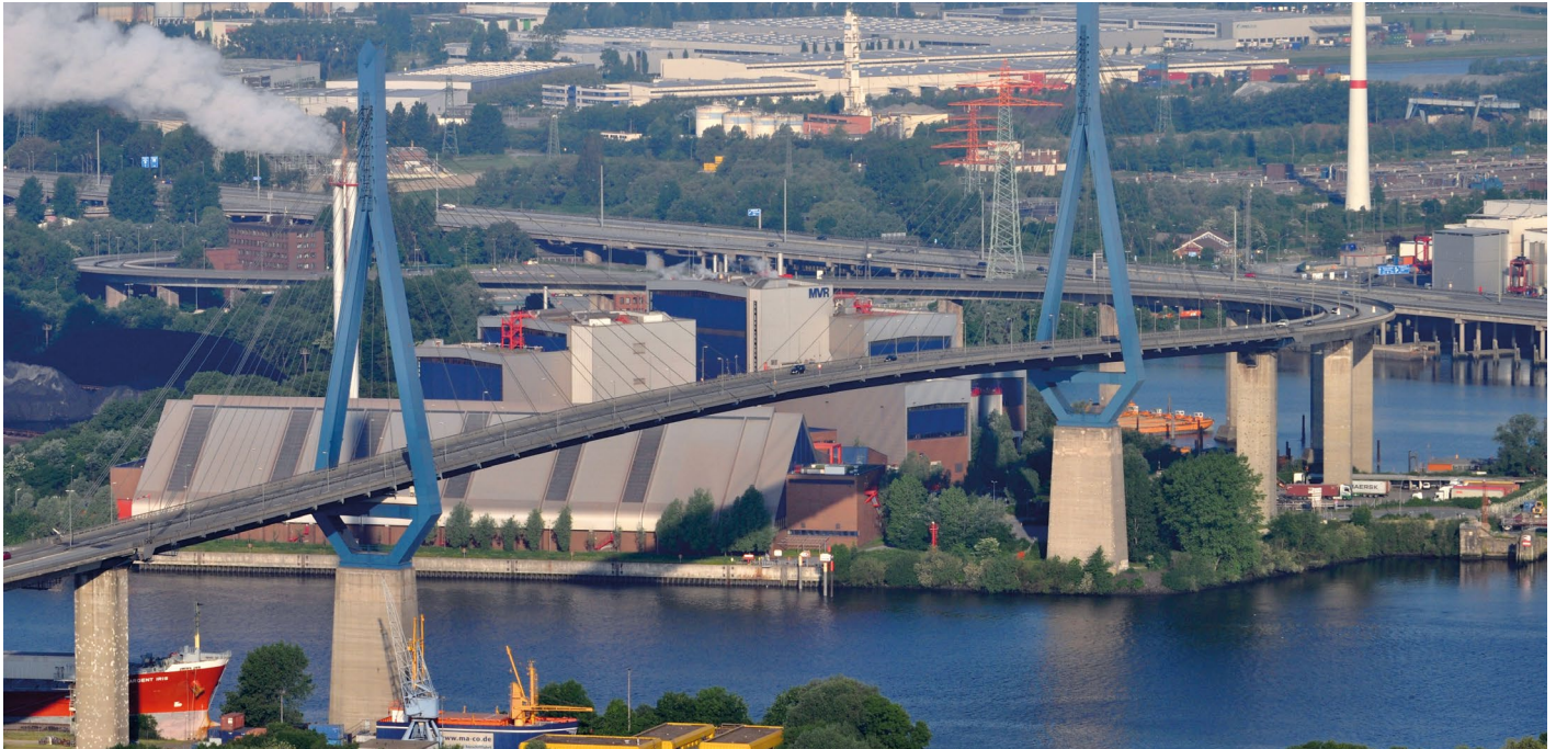
Die Köhlbrandbrücke auf einer Aufnahme von 2013. Deutlich werden die Dimensionen des Bauwerks und die Tragweite der Entscheidung über eine Alternative.
