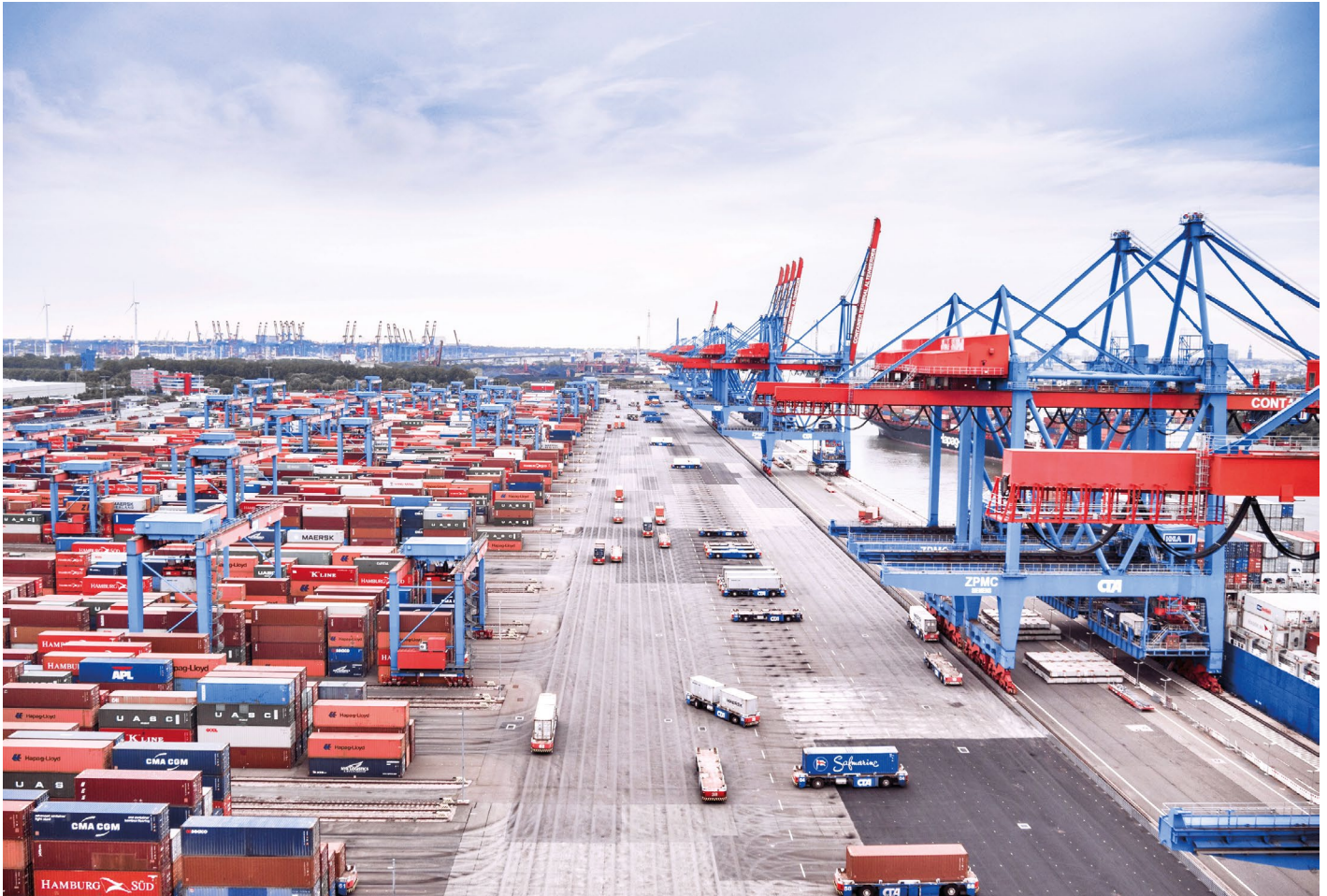
Baustelle Hafen. Nicht immer ziehen Politik und Wirtschaft an einem Strang. Das wird besonders an Infrastrukturen wie der Elbvertiefung deutlich.
